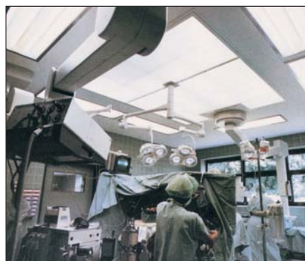
Obr. 5 Přívodní stropy Luwa® CG pro operační sály
